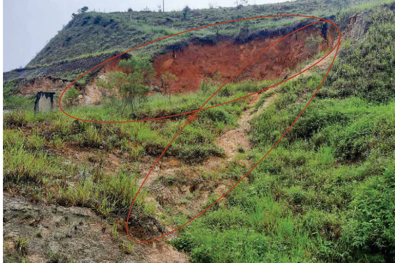
Figura 51: Talude 13 - Rompimento em Solo.
