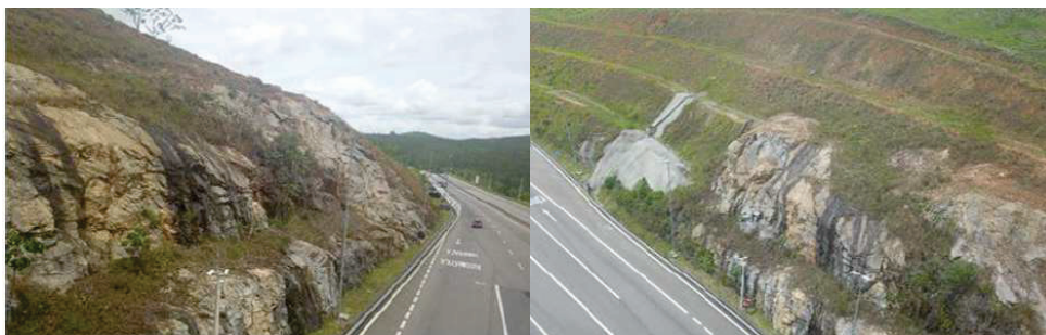
Figura 75: Talude 10 - Afloramento rochoso, concreto projetado e vegetação.
