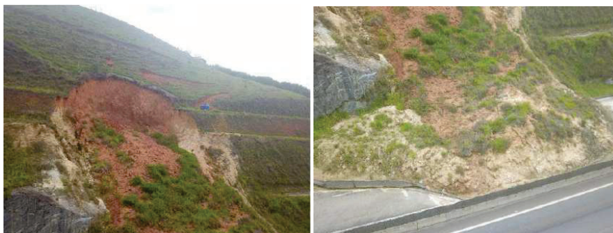
Figura 66: Talude 13- Trecho 2 rompido.
