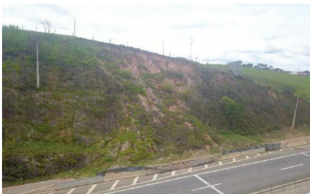
Figura 31: Talude 04 - Talude rompido por escorregamento.
