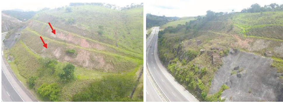
Figura 46: Talude 11 - Local necessário revegetação e parede em concreto projetado.
