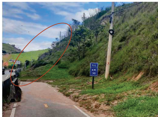
Figura 18: Talude 04: Obstrução da ciclovia devido a escorregamento.
