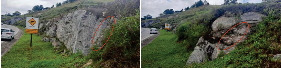
Figura 9: Talude 01 - Afloramento de Rocha fraturado.
