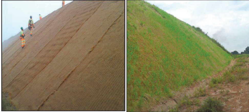
Figura 68: Taludes Ambientais - Exemplo de aplicação de biomanta e recuperação.
