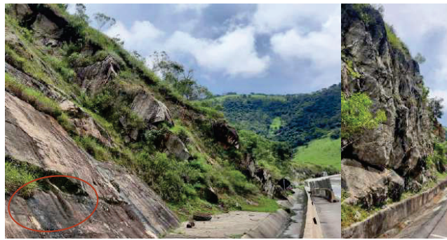
Figura 36: Talude 11 - Deslocamento de blocos e paredão fraturado.
