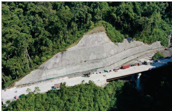
Figura 119 - Contenção tipo solo grampeado.
